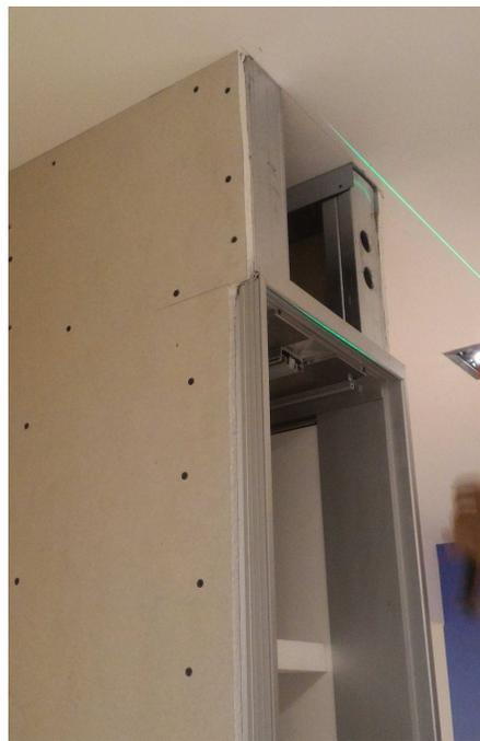
Procedere fissando le lastre di cartongesso direttamente contro i montanti del controte laio (usando viti da 19mm per lastre da 12,5mm non sfondano all'interno) o contro gli appositi profili da cartongesso.
