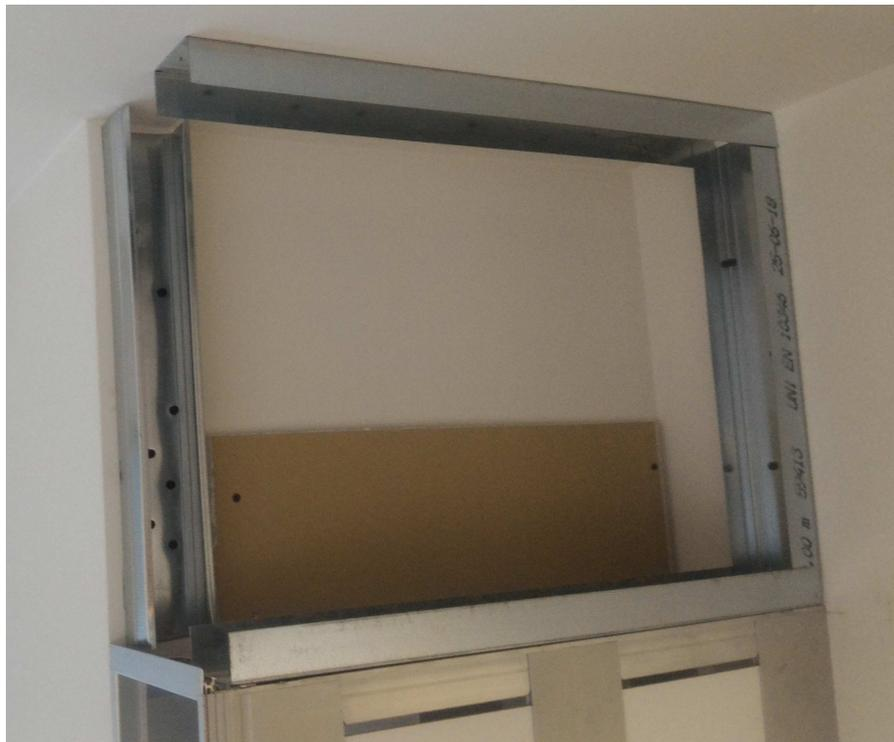
Procedere realizzando una struttura adeguata per raggiungere la quota del soffitto. Se necessario rinforzare la struttura inserendo dei traversi in legno all'interno dei profili per cartongesso.
