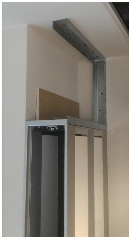
Fissare la parte posteriore, inserendo nel muro dei tasselli idonei alla tipologia (muratra, cartongesso, ecc...) usando le apposite squadrette, già montate sui montanti posteriori.
