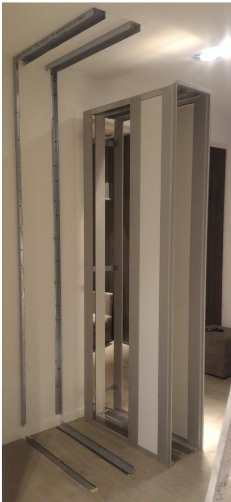
Predisporre una struttura (a parete e a soffitto) alla quale poter fissare il controte laio, usando dove necessario, dei tasselli idonei alla tipologia di parete. Non è necessario forare il pavimento.
